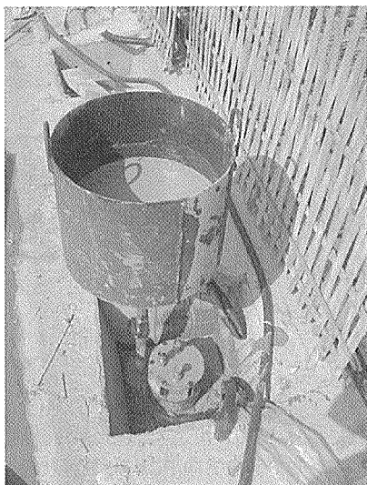
写真 - 11 鉛直方向 PC グラウトの補充容器
