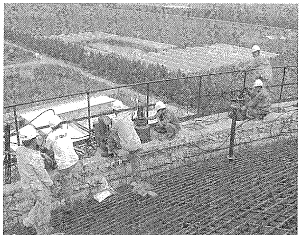
写真-9 鉛直方向 PC 鋼材緊張状況
