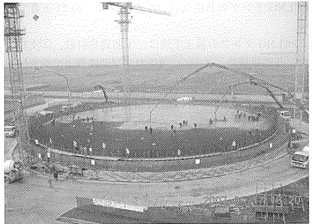
写真 - 3 基礎版コンクリート打設状況
