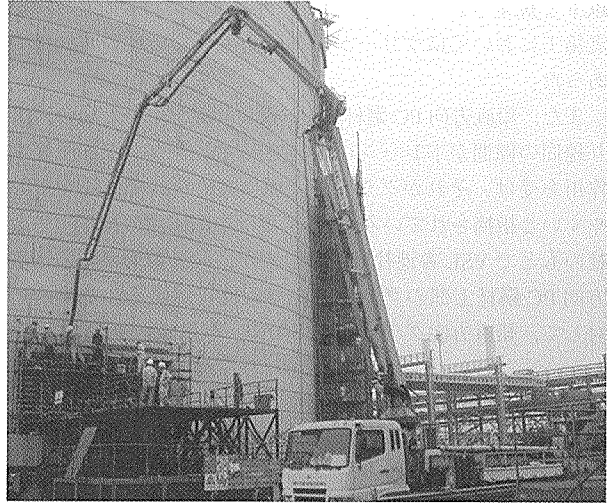
写真-8 工事用開口部コンクリート打設状況
