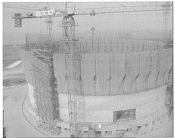
写真 - 4 PC 壁の足場型枠装置
