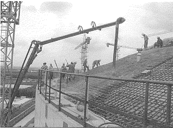
写真-6 RC屋根コンクリート打設状況
