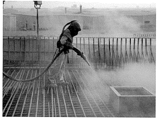
写真-9 鉄筋のサンドブラस्टング
