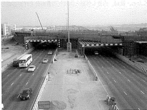
写真 - 6 鋼製門型支保工施工区間
