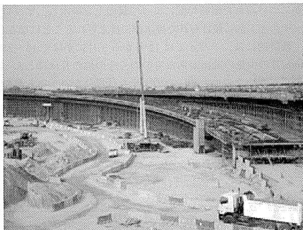
写真 - 5 枠組支保工施工区間
