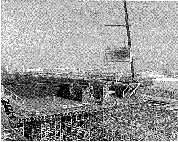
写真-8 プレファブ鉄筋の吊込み
