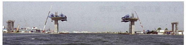
写真 - 7 移動作業車による主桁の架設状況
