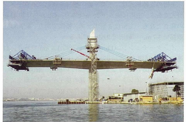
写真 - 7 移動作業車による主桁の架設状況
