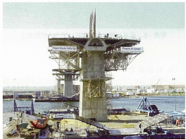
写真-4 柱頭部完成後（支保工解体）の状況
