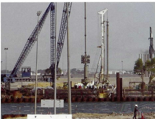
写真-2 場所打ち杭の施工状況
