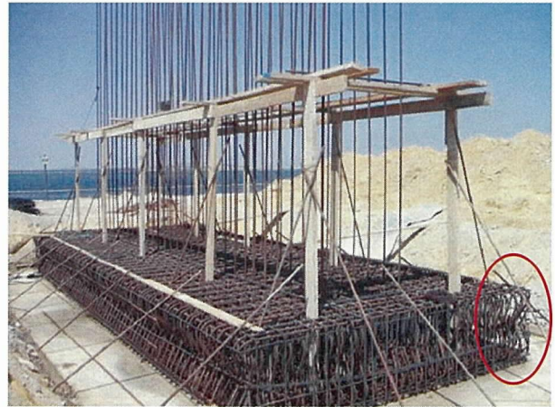
写真 - 12 フーチングの配筋状況
