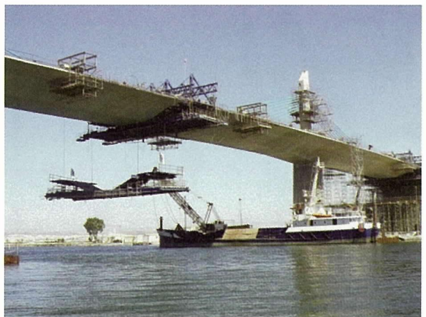
写真 - 9 中央閉合後の移動作業車のジャッキダウン
