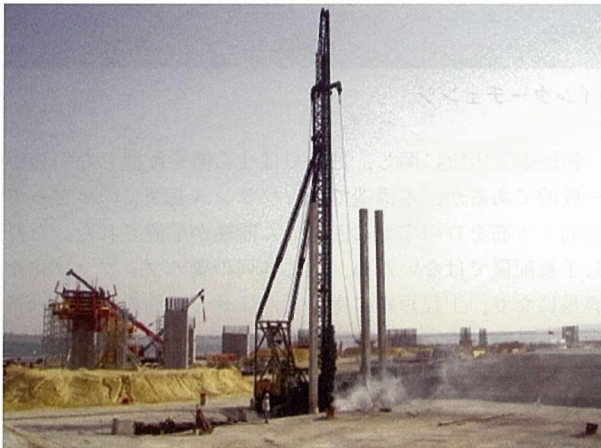
写真 - 11 RC 杭のハンマー打設
