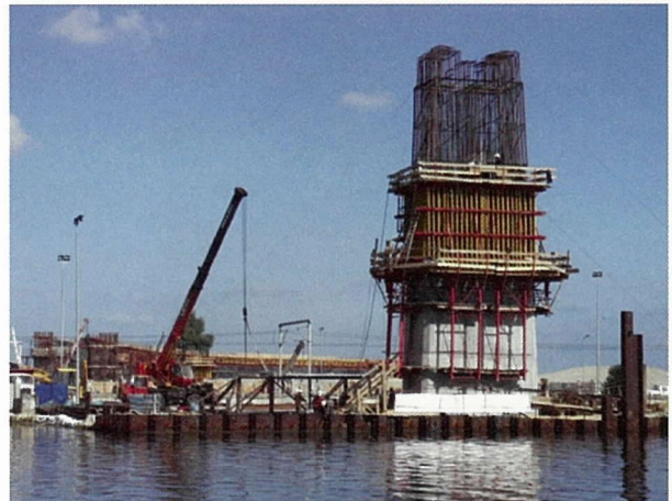
写真-3 主橋梁の橋脚の施工状況
