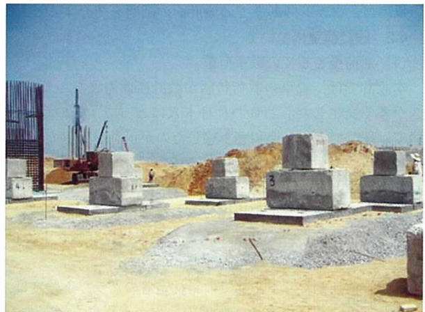
写真 - 14 支保工基盤の載荷試験
