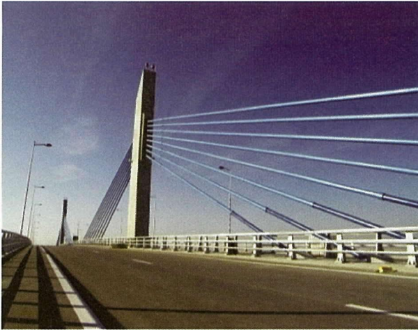
写真 - 10 主橋梁の完成後の橋面
