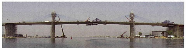
写真 - 8 主桁の張出し状況
