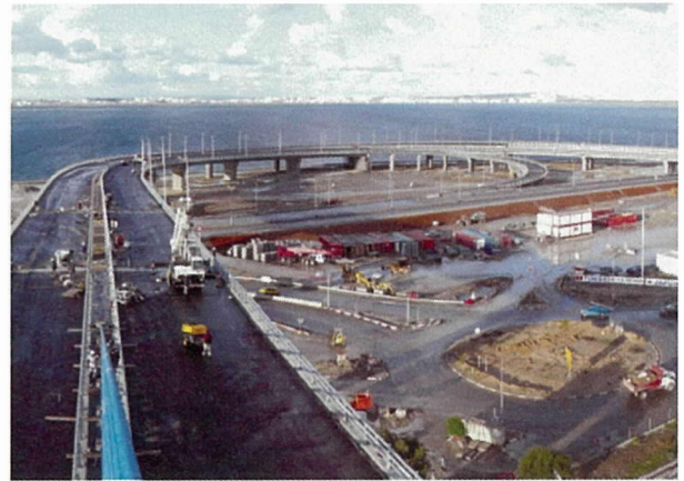
写真 - 17 舗装完了後のインターチェンジ
