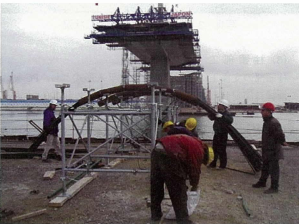
写真 - 6 サドル部の斜材定着に関する試験施工
