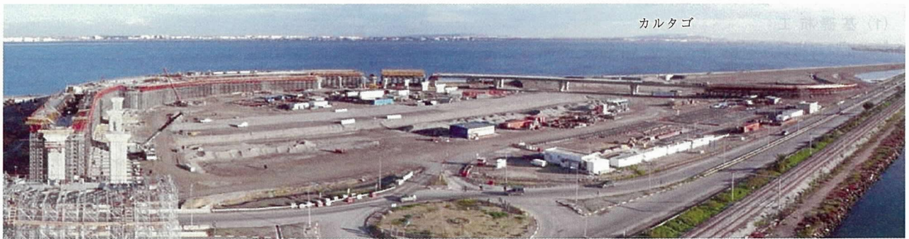
写真 - 16 上部工施工中のインターチェンジ
