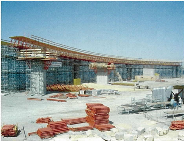
写真 - 15 上部工の支保工・型枠の設置状況
