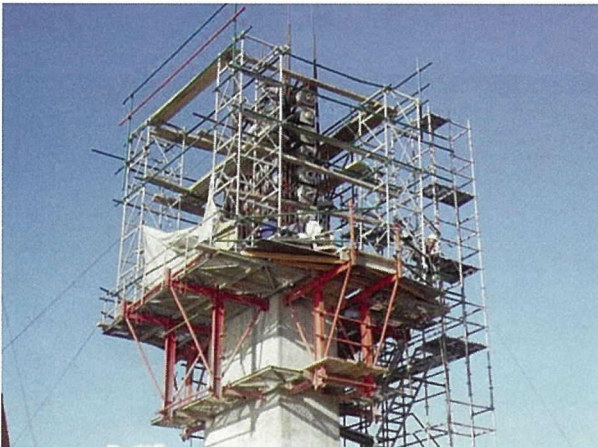
写真 - 5 主塔に設置したサドル
