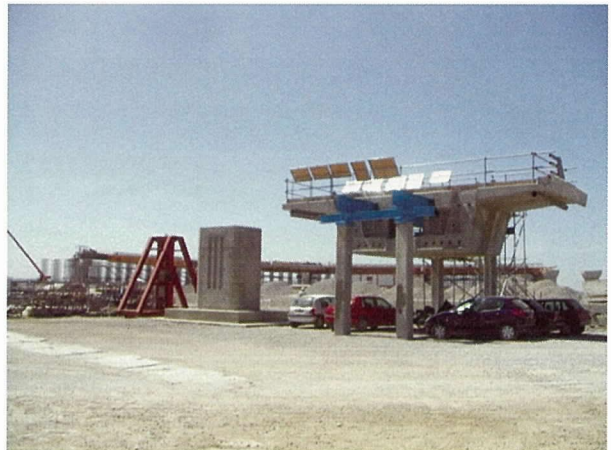
写真 - 13 試験施工で製作した橋脚と桁
