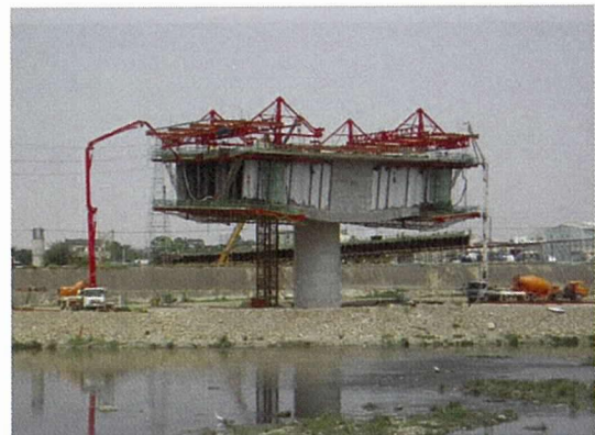
写真 - 13 コンクリート打設状況
