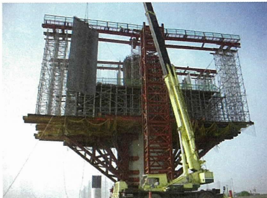
写真 - 11 ブラケット式支保工 (C707 / UNIT3 : P13 柱頭部)
