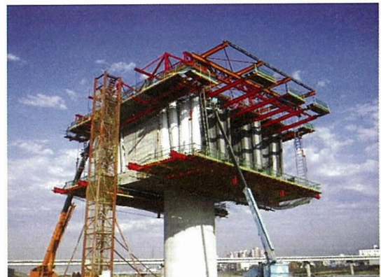
写真 - 12 移動作業車全景
