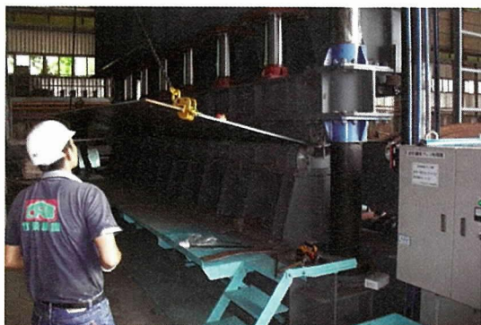
写真 - 7 鋼板への波付け状況
