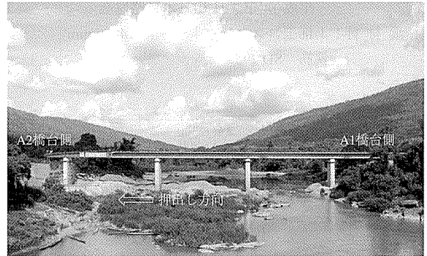
写真 - 2 押し出し架設時の全景
