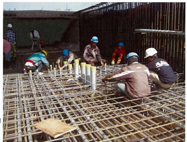
写真 - 5 押出しケーブル定着部の補強状況
