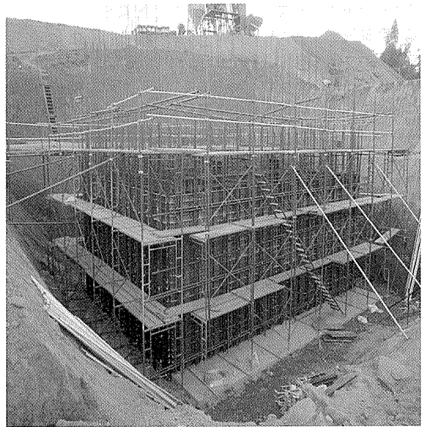
写真 - 7 A 1 橋台型枠組立て状況
