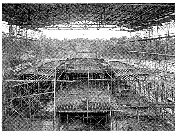
写真-3 桁製作ヤード (A1 橋台側)
