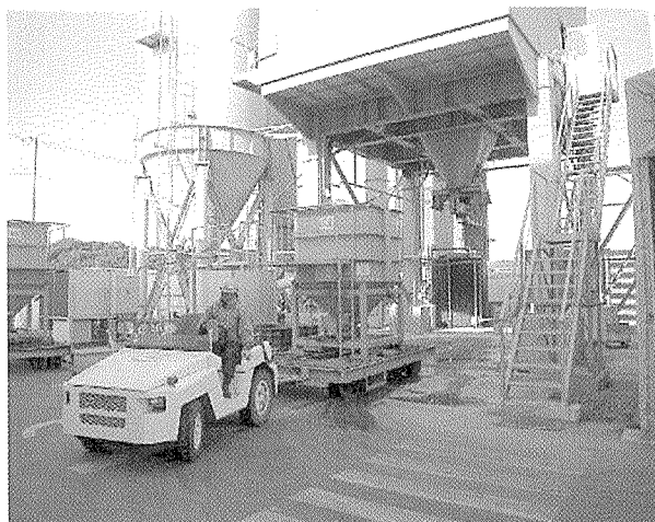
写真 - 8 UFC 運搬状況
