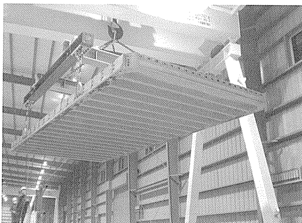
写真 - 12 床版運搬状況
