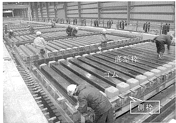
写真 - 4 型枠組立て状況
