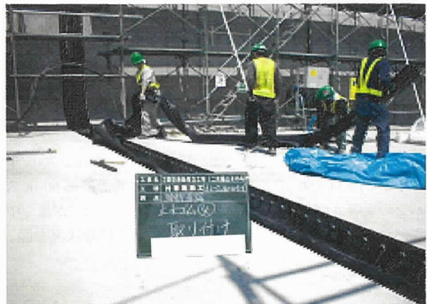
写真-2 可とうゴム取付け
