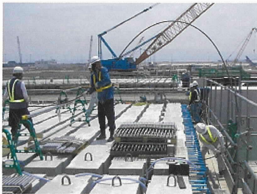
写真 - 3 横締めケーブル挿入状況
