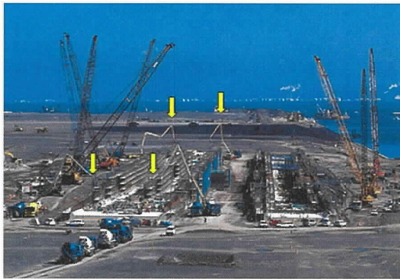
図-7 コンクリート打設状況 (↓は打設箇所)
