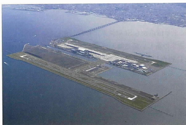
写真 - 1 関西国際空港全景（上：1 期島，下：2 期島）
