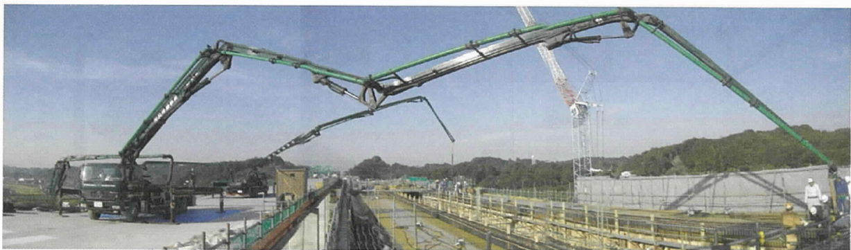
写真-2 P 10 - P 11 径間コンクリート打設状況（第 1 ロット）
