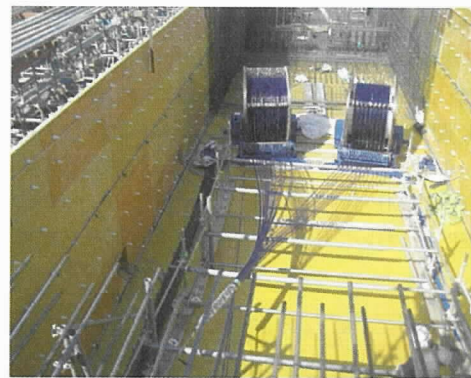
写真-3 外ケーブル挿入状況（27S15.2）
