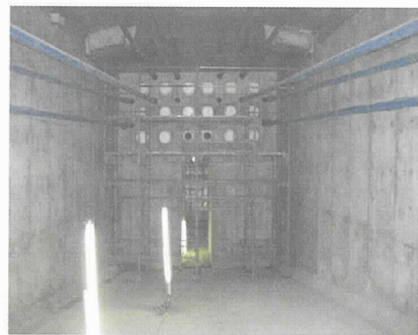
写真-4 外ケーブル定着状況（27S15.2）
