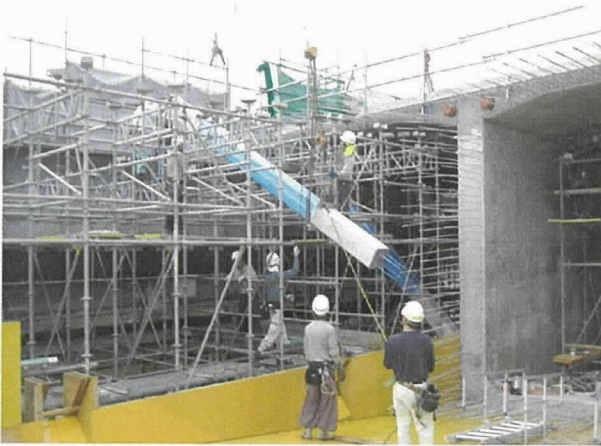
写真-1 ストラット設置状況
