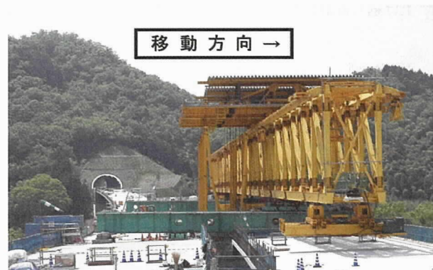
写真-6 架設桁横移動完了状況
