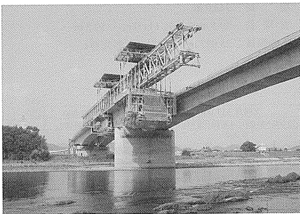
写真 - 2 外回り線施工状況
