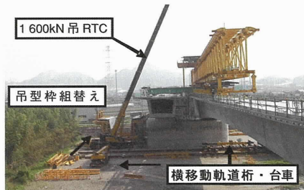
写真-5 吊型枠横移動・組替え状況
