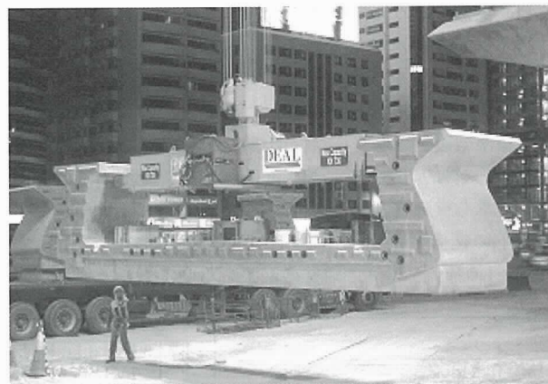
写真 - 4 Spreader beam 使用状況
