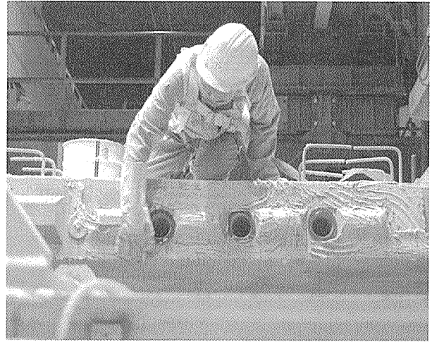
写真-7 接着剤塗布作業状況
