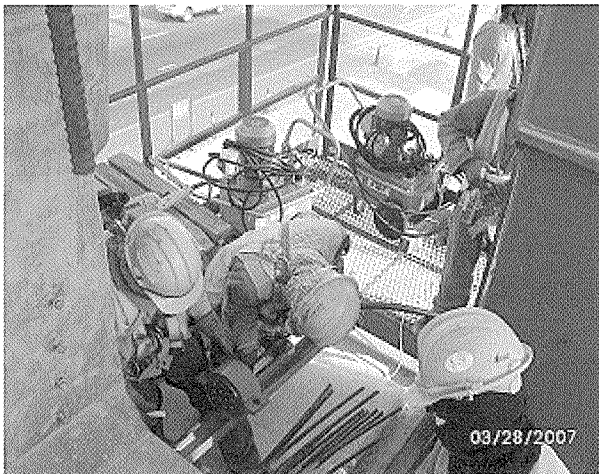
写真 - 8 PC鋼材挿入状況
