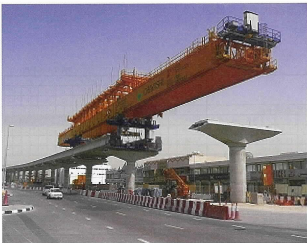
写真 - 2 架設桁全景写真
