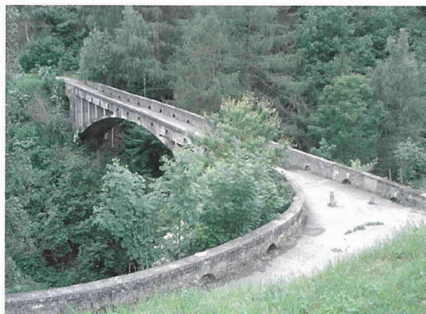
写真-3 下流側左岸の上部からのワルチール橋
