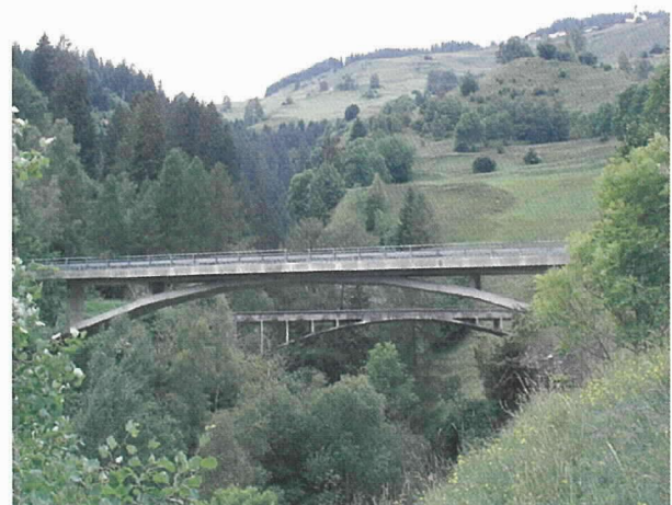
写真-6 下流側からの新旧ワルチール橋（手前が新ワルチール橋）
