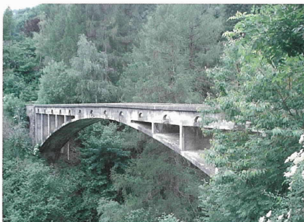
写真-2 下流側左岸からのワルチール橋
