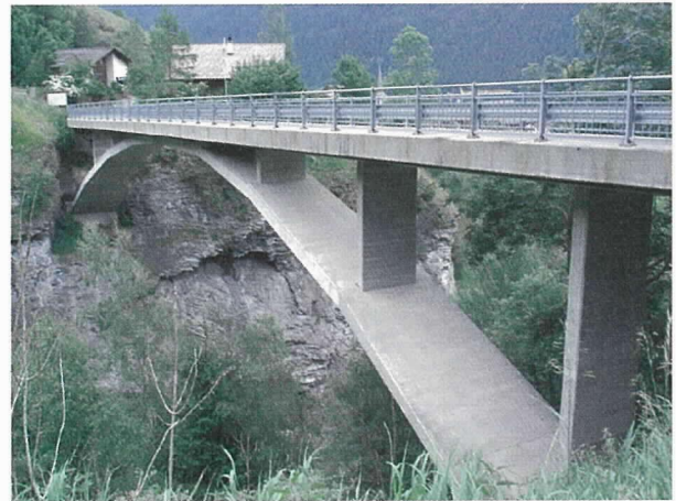
写真-5 上流側右岸からの新ワルチール橋
