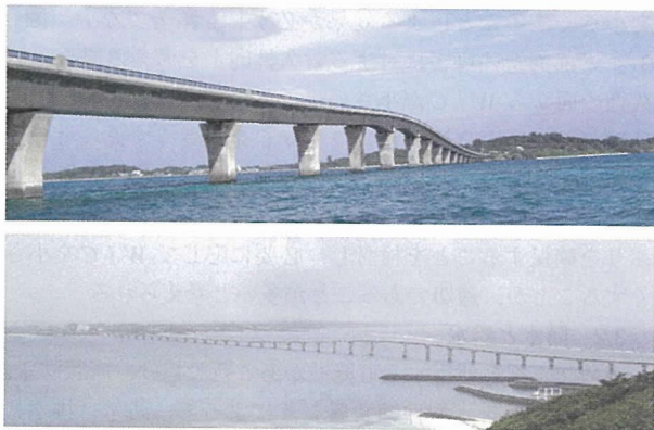
写真 - 9 離島架橋の橋脚群 (上：池間大橋，下：来間大橋)
