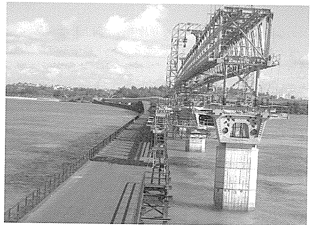
写真-6 架設桁
