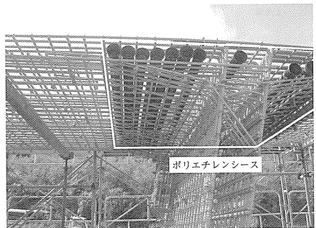
写真 - 3 ポリエチレンシースの配置状況
