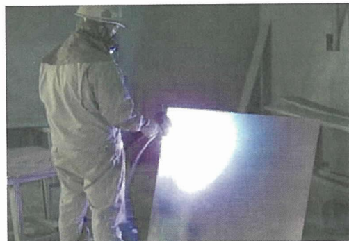
写真 - 5 AIMg 溶射実施状況
