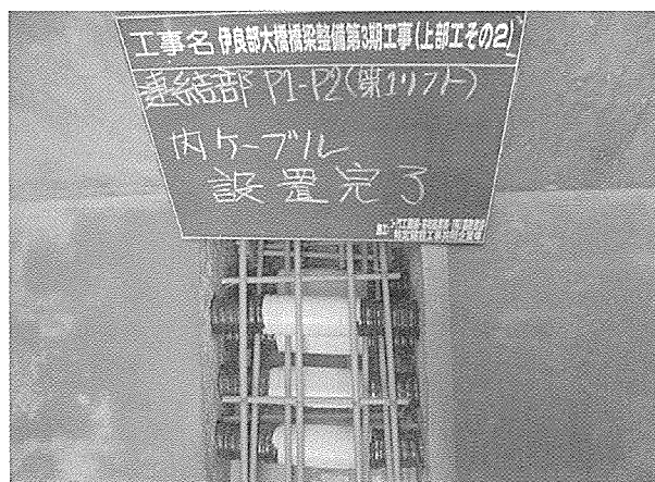
写真-10 連結部シーソ配置状況
