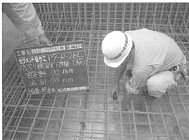
写真-8 鉄筋かぶり確認状況
