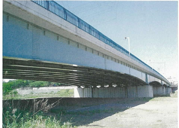
写真 - 4 改修された聖橋（高崎市）
