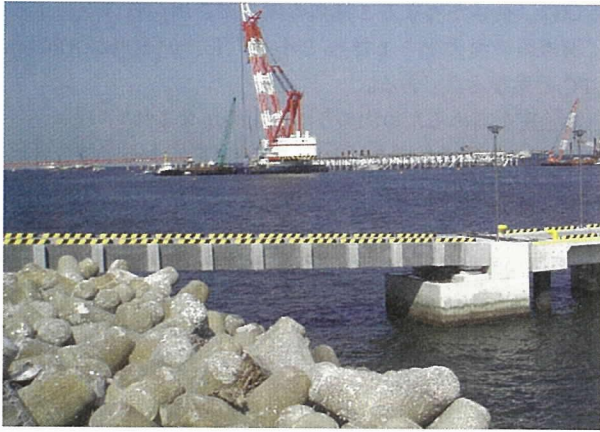
写真-5 管理用棧橋渡り橋
