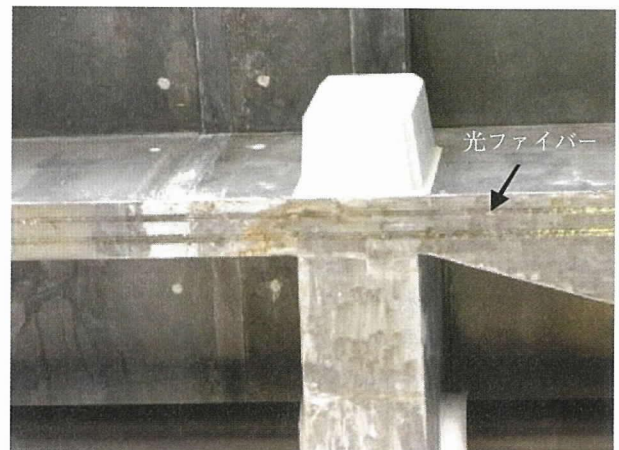
写真-7 光ファイバー貼付箇所
