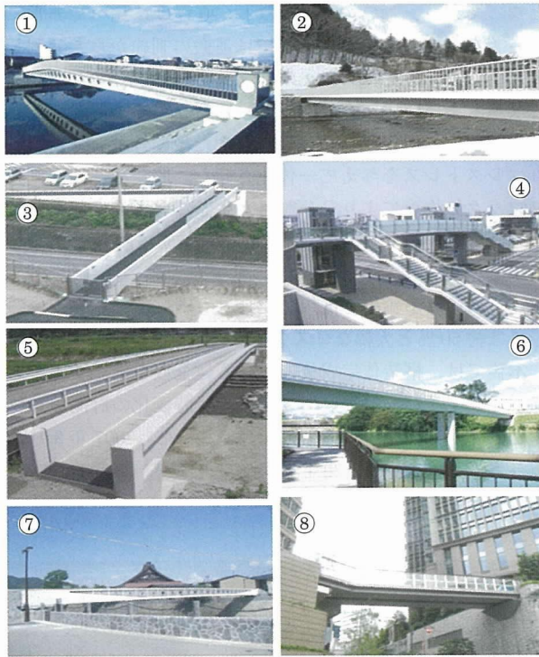
写真-2 RPC系UFC歩道橋
