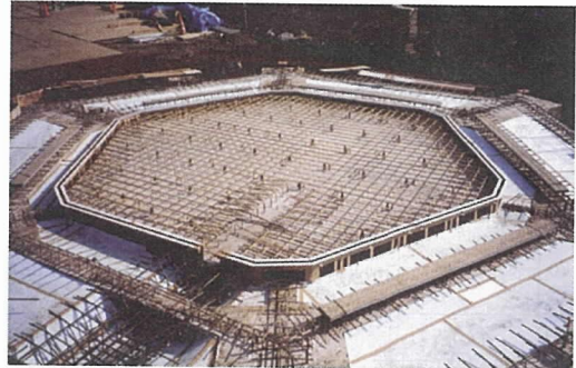
写真-5 基礎構造物
