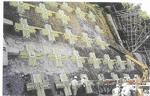
写真-6 グラウンドアンカー
