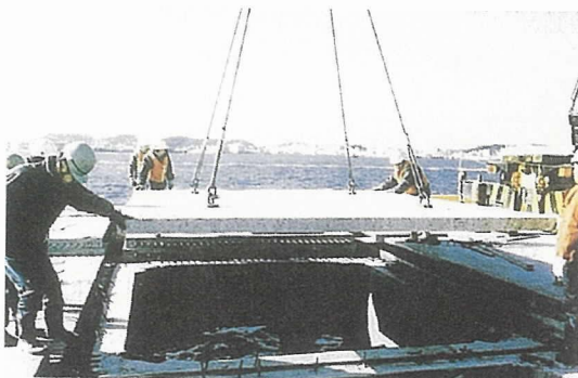
写真-4 海洋構造物
