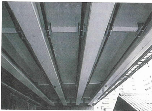
写真-3 PC桁補強
