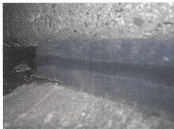
写真 - 2 供用30年以上のポステン桁のパッド型ゴム支承
