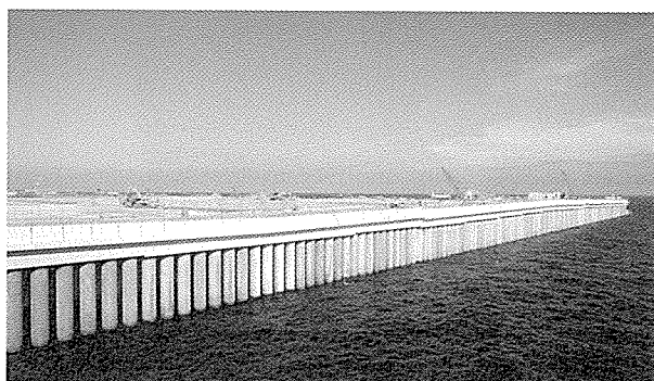
写真 - 8 消波護岸完成状況
