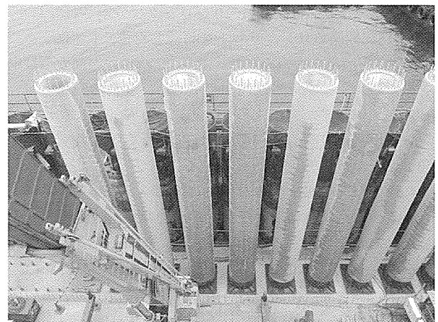
写真-5 スリット柱建込み状況
