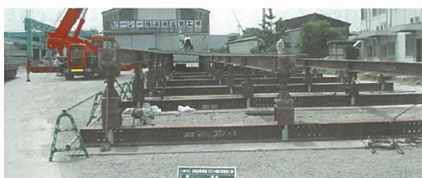
写真 - 1 仮組状況
