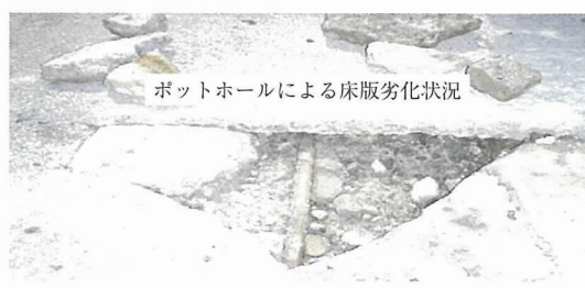
雨水による SFRC の泥化状況
