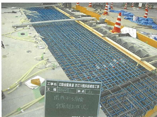
写真-9 場所打ち床版 鉄筋配置状況
