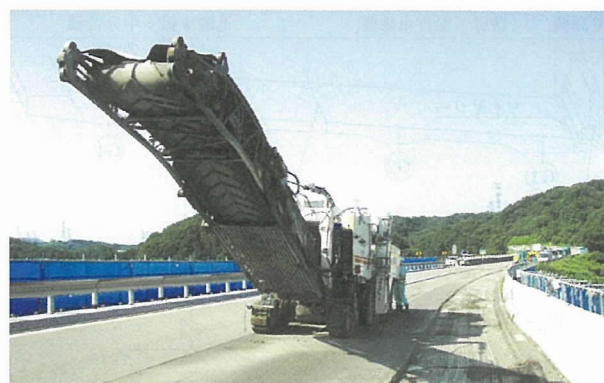
写真 - 3 アスファルト舗装 (SFRC) 切削状況
