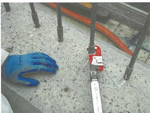
写真-10 機械継手鉄筋配置状況
