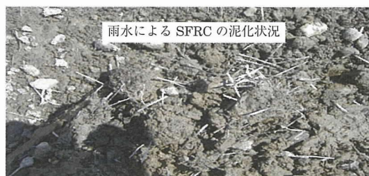
写真 - 4 ポットホールによる劣化と SFRC の泥化部分の状況
