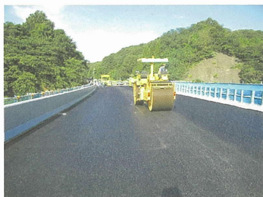
写真-12 アスファルト舗装施工状況
