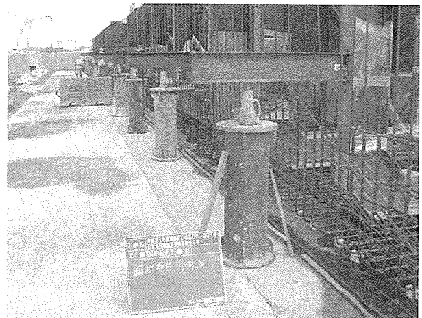
写真 - 4 鋼桁受け台設置状況
