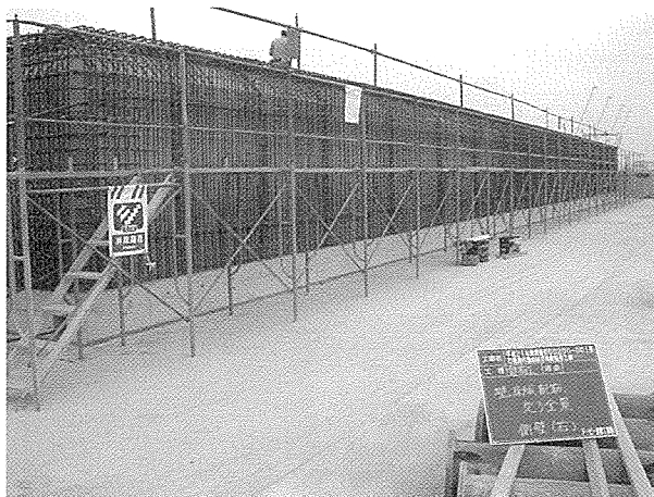
写真 - 5 鉄筋および PC 鋼材組立て状況
