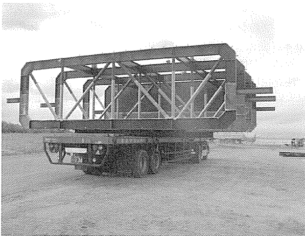
写真 - 2 鋼桁運搬状況
