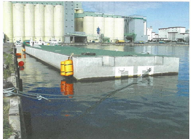
写真 - 15 仮係留完了
