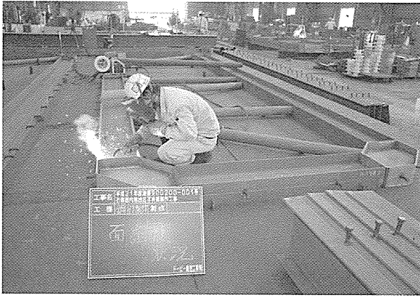
写真 - 1 鋼桁製作状況
