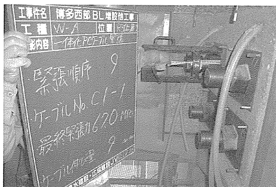
写真-12 RC高架橋一体化PC鋼材緊張作業状況
