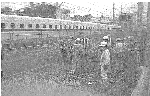
写真 - 3 コンクリート打設状況
