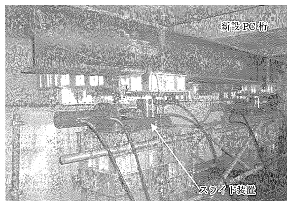
写真 - 4 1 000 kN スライド装置設置状況
