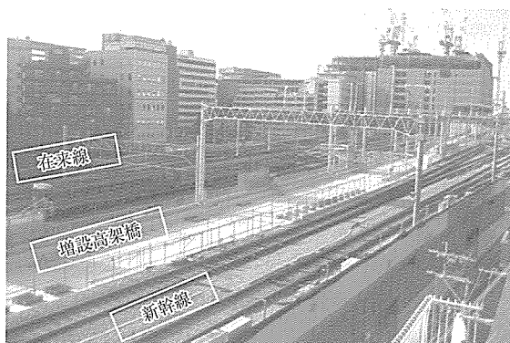
写真-13 完成写真
