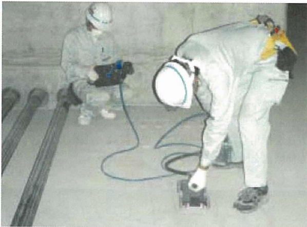
写真-5 非破壊検査によるグラウト充てん確認状況
