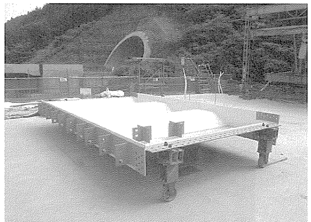
写真-4 波形鋼板の運搬状況
