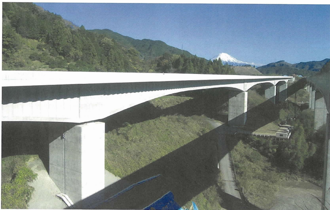
写真-6 中一色川橋（上り線）完成写真
