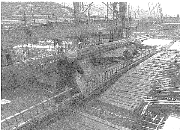
写真-2 型枠内への水平リブのプレファブ鉄筋配置
