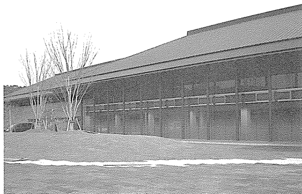
写真・1 建物外観
