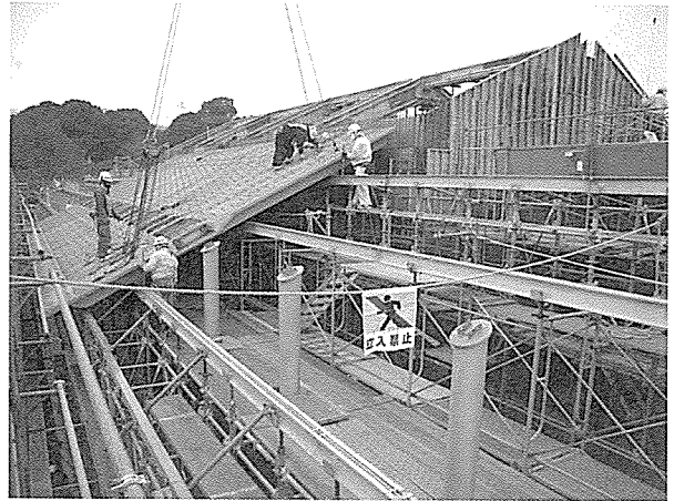
写真-11 PC版架設状況
