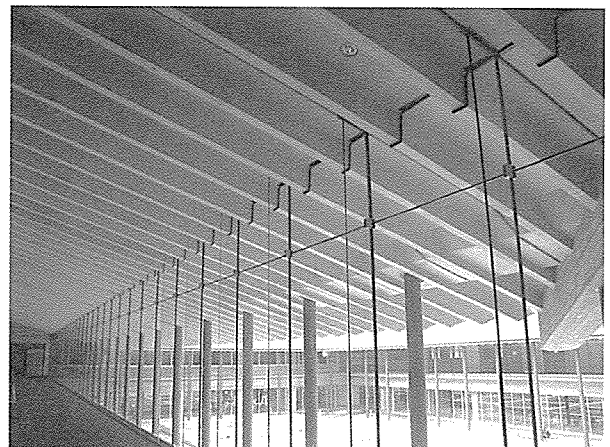
写真-13 PC合成床版内観
