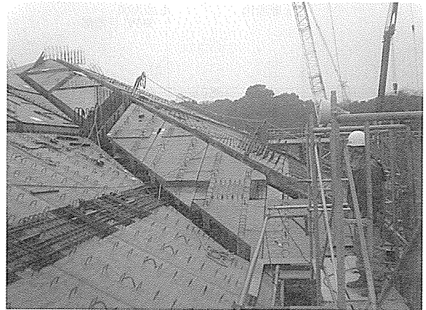
写真-12 PC版出隅・入隅部架設状況
