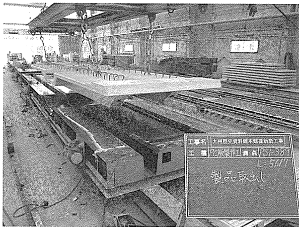
写真-10 PC版脱枠状況
