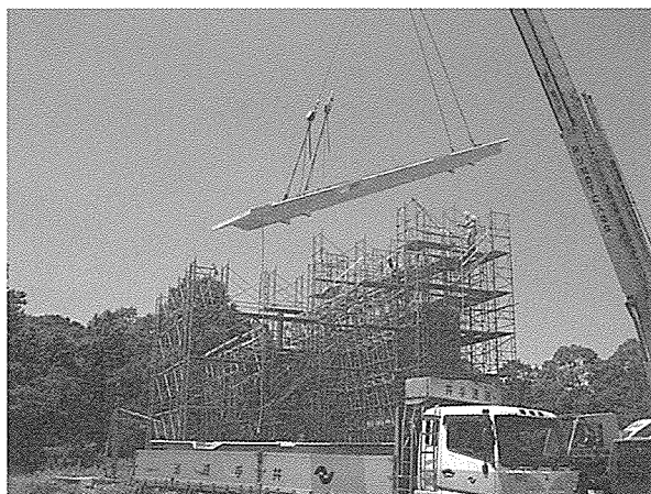
写真 - 7 見本版架設状況
