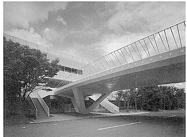
写真 - 12 ブリッジ完成写真
