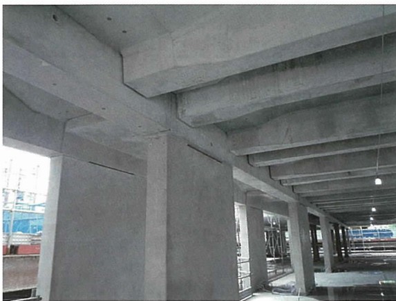
写真 - 2 鋼管柱と PCaPC 間柱
