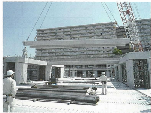
写真 - 3 施工中写真
