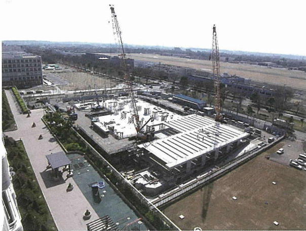
写真 - 4 PC建て方全景
