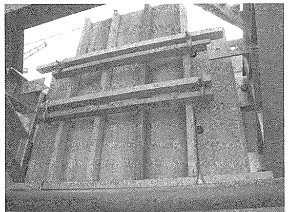
写真 - 10 緊張端型枠取付け
