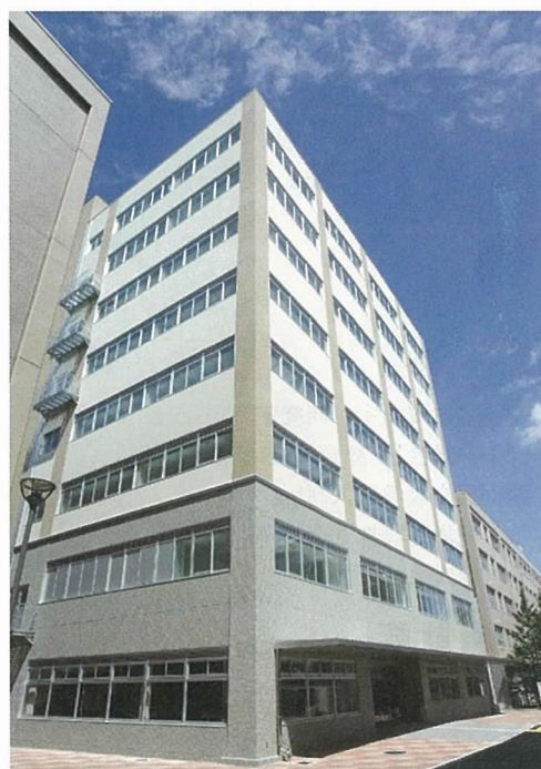
写真 - 1 竣工時外観
