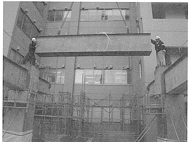
写真 - 4 桁梁仮設状況
