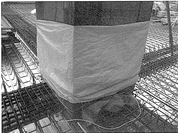
写真 - 6 柱脚部の養生
