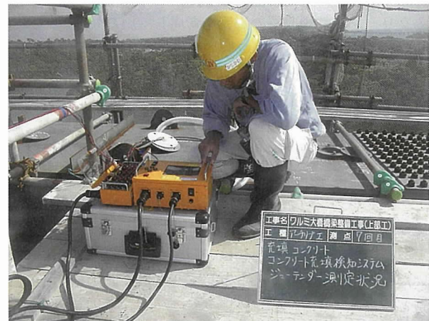
写真 - 3 充てん検知センサー測定状況
