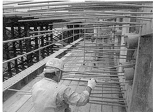
写真-7 防錆モルタル塗布状況
