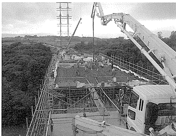
写真-6 補剛桁コンクリート打設状況
