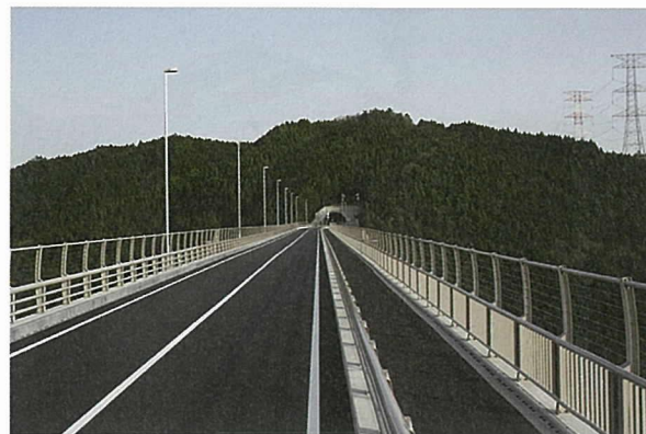
写真 - 5 新旅足橋全景 (A1 橋台付近より)
