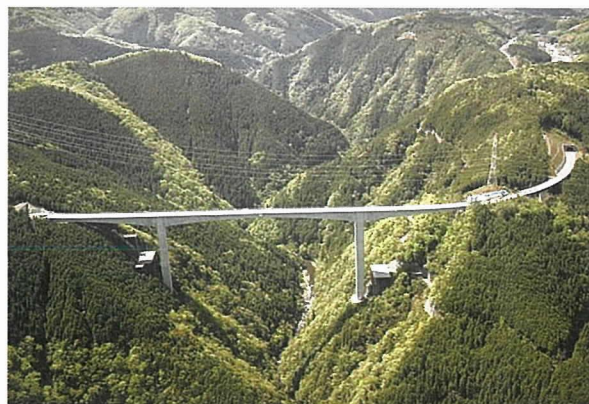
写真 - 7 新旅足橋全景 (下流側上空より)
