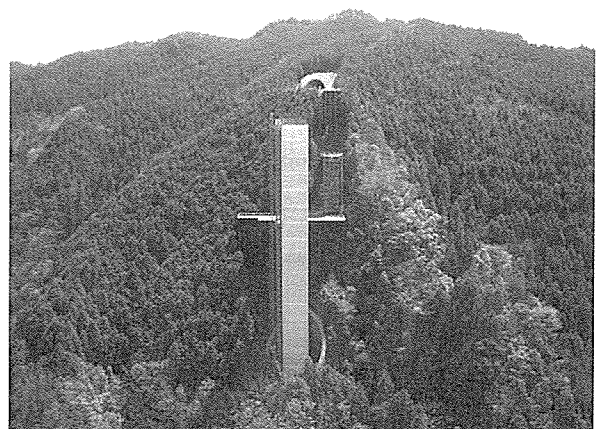
写真 - 1 P2 橋脚の作業構台
