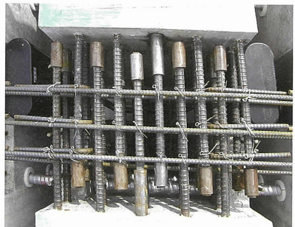
写真 - 2 連結部の配筋状況
