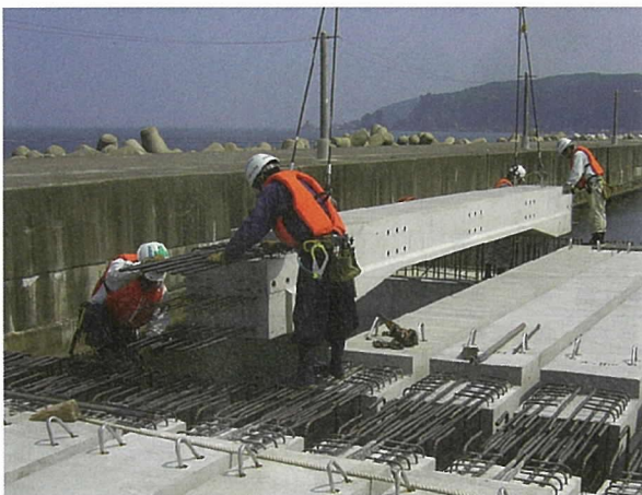
写真 - 1 PC 栈橋の施工例
