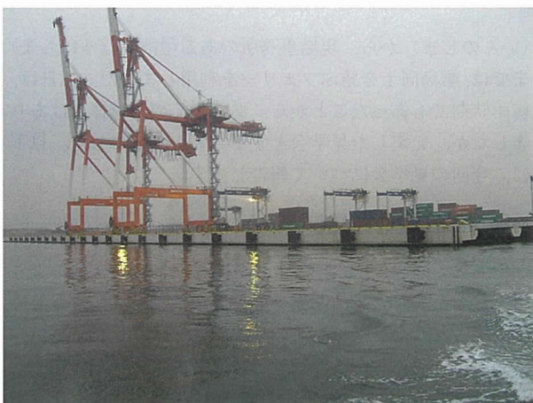
写真 - 2 代表的な施工例 (四日市港霞ヶ浦北ふ頭 80 号岸壁)
