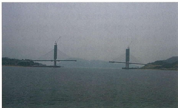
写真 - 1 フェリーから見た生名橋現場
