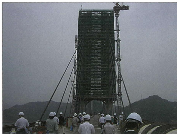
写真 - 3 佐島側から見た見学状況
