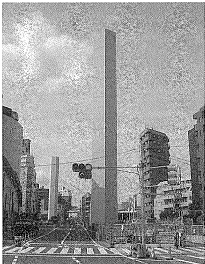
写真 - 5 トンネル換気塔
