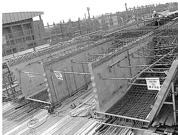
写真 - 7 プレテンションウェブ橋の施工
