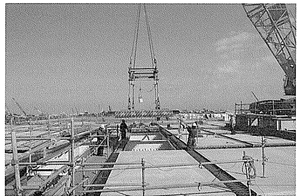
写真 - 3 羽田空港D滑走路栈橋部プレキャストPC床版
