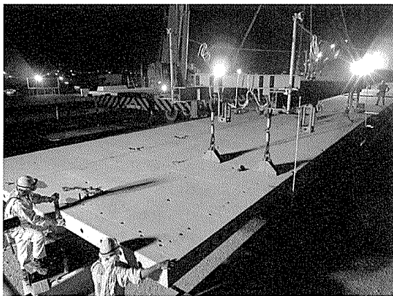
写真 - 1 那覇空港エプロン舗装改修
