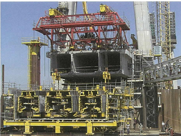
写真 - 2 鉄筋・型枠設備の一括吊込み (提供：D. Tisminetzky 氏, Waiko Group)
