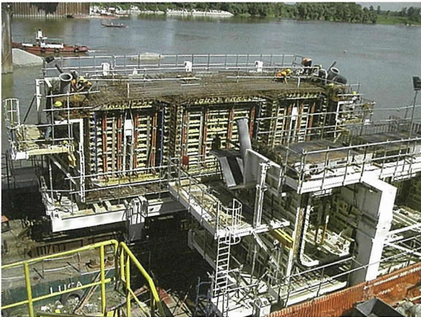
写真 - 1 台船による鉄筋・型枠設備の曳航 (提供：D. Tisminetzky 氏, Waiko Group)
