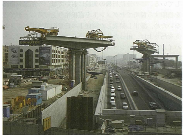
写真 - 3 モバイル型エレクションノーズ (提供：山口貴志氏, ㈱大林組)
