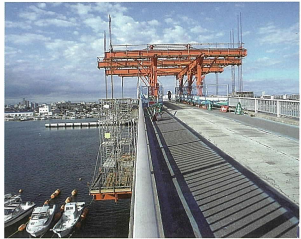
写真-4 移動作業車を用いた既設橋の床版拡幅
