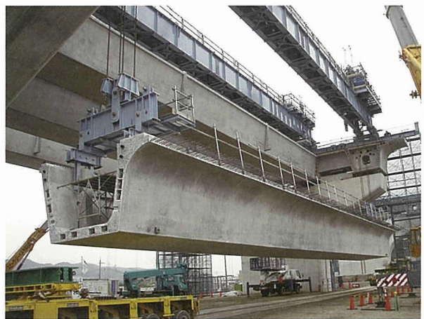
写真-6 U桁架設による架設ガーダーの軽量化
