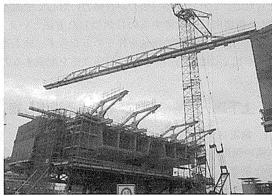
写真-5 上部トラス梁架設
