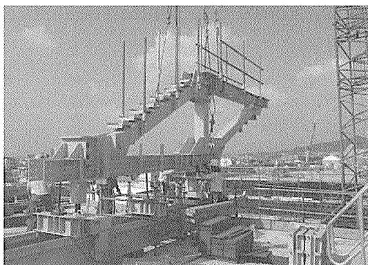
写真-4 メインフレーム架設
