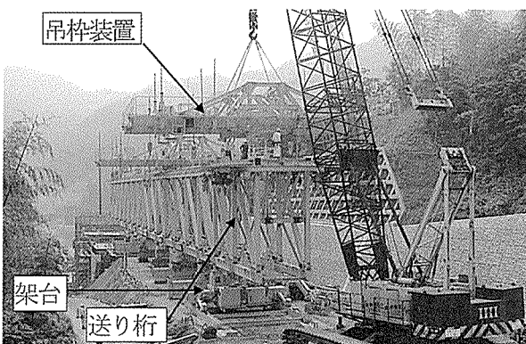
写真-8 架設桁組立て状況
