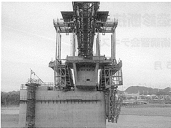
写真-13 橋脚通過時 開閉状況
