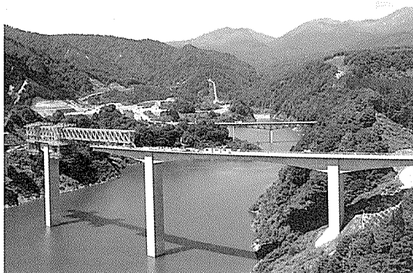
写真 - 1 湖上・高橋脚施工例（月山橋）
