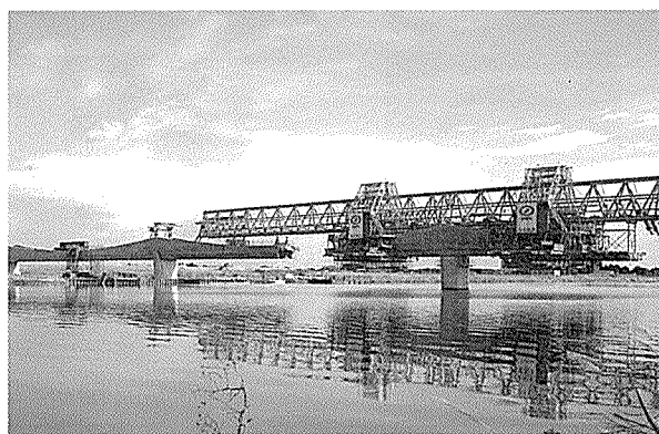
写真 - 4 河川上施工例（鳴瀬川橋りょう）
