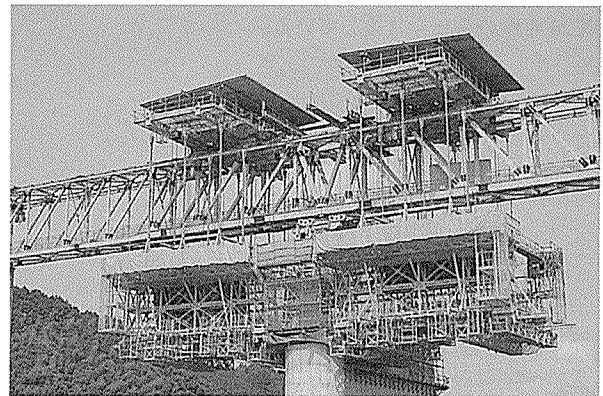
写真-15 柱頭部施工時 吊型枠状況
