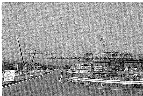
写真-12 送出し施工状況
