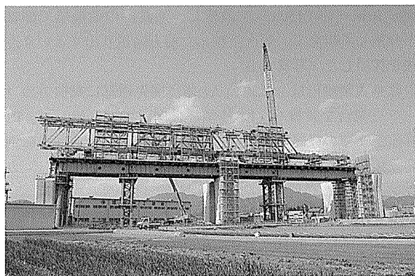
写真-11 架設桁組立て状況
