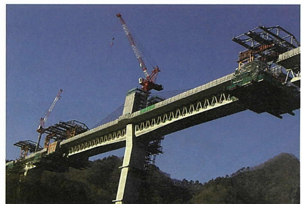
図 - 14 張出し架設状況
