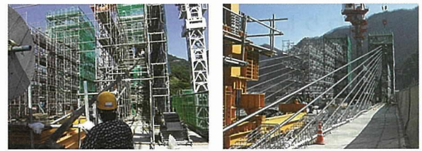
図-20 斜材ケーブルの架設状況と架設完了全景
