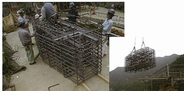
図 - 18 主塔帯鉄筋の地組・架設
