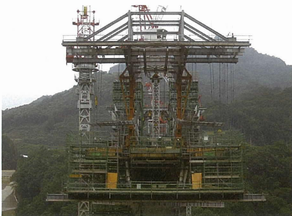
図 - 15 超大型移動作業車
