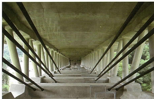
図 - 17 桁内空部と架設外ケーブル配置状況
