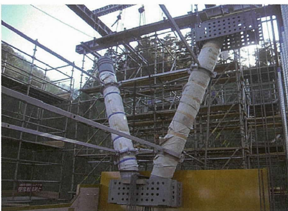
図 - 16 鋼トラス材固定状況
