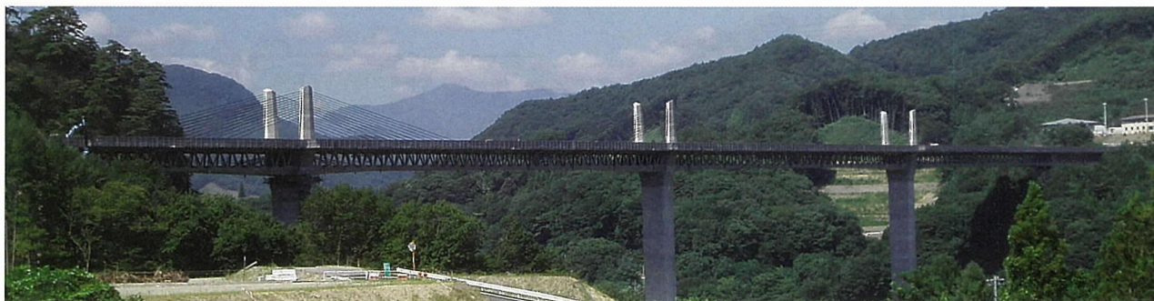
図 - 24 構造系完成 全景写真
