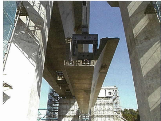
写真 - 16 U桁リフティング架設状況
