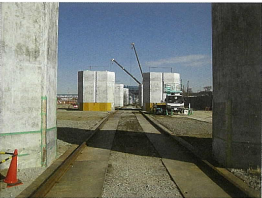
写真 - 14 運搬台車軌道
