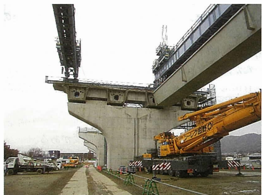
写真 - 4 U桁横移動状況
