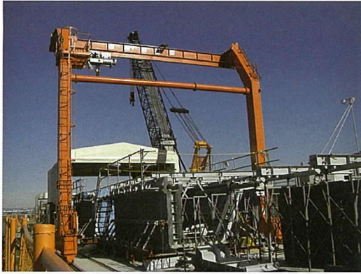
写真 - 12 U型セグメント製作設備
