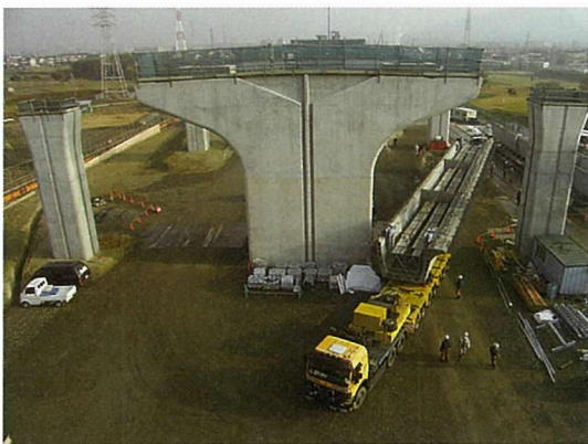
写真 - 2 U桁の場内運搬
