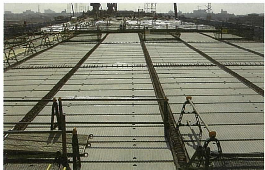
写真 - 5 PC板敷設完了
