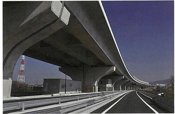
写真 - 17 茄子作地区高架橋 完成全景
