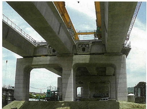
写真 - 10 主桁の横移動状況
