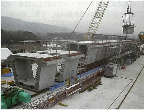
写真 - 6 主桁の組立て状況
