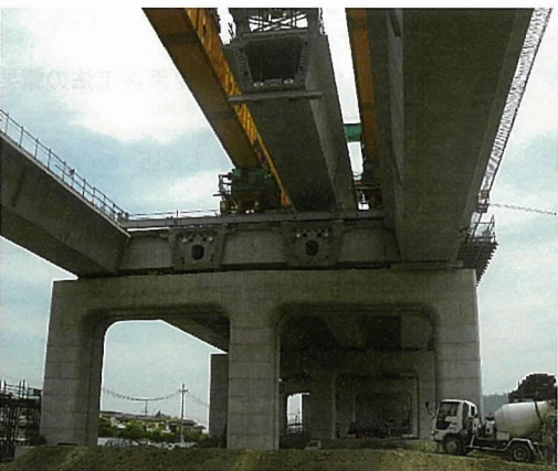
写真 - 8 架設ガーダーによる主桁架設
