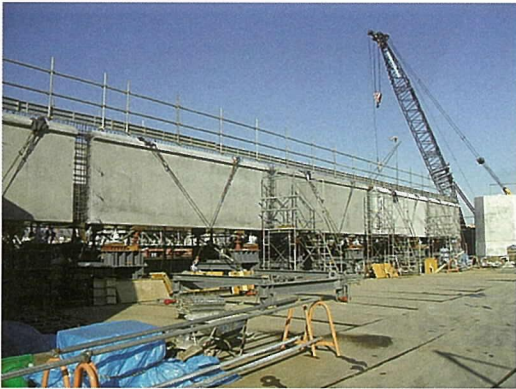
写真 - 13 U桁の組立て状況
