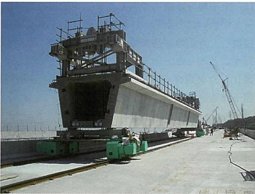
写真 - 7 主桁の橋面運搬
