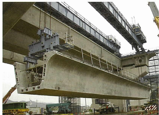
写真 - 3 U桁リフティング架設状況
