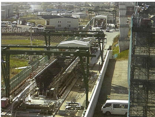
写真 - 1 U桁製作ヤード全景
