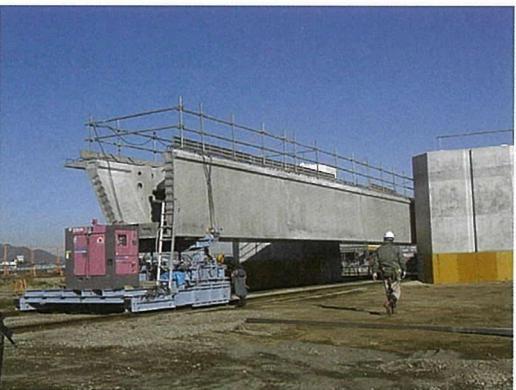
写真 - 15 U桁の台車運搬
