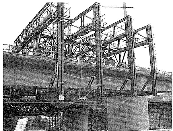
写真 - 5 移動作業車組立て状況
