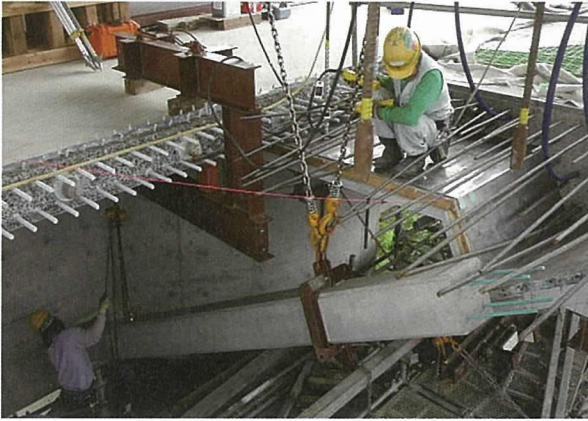
写真 - 7 ストラット吊込用ビーム
