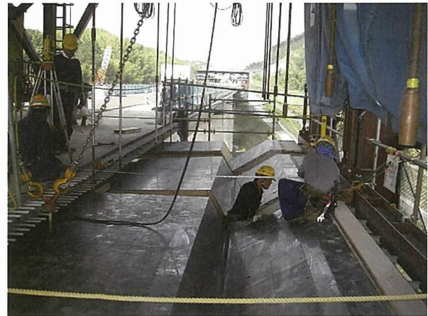
写真 - 10 鋼製型枠組立て状況
