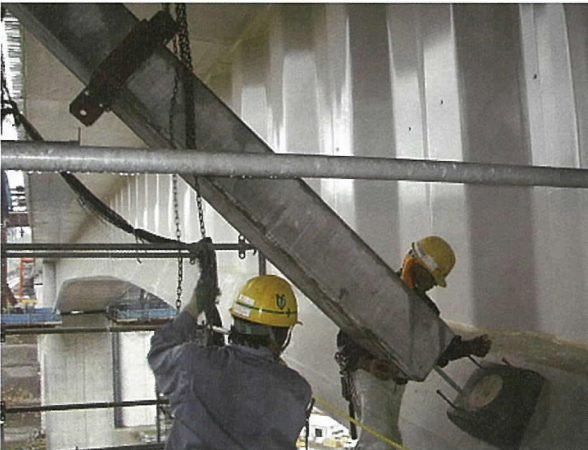
写真 - 8 ストラットセット状況
