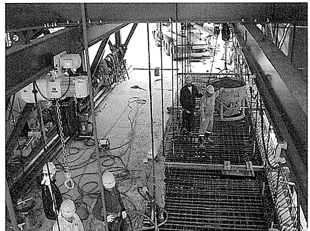
写真 - 14 コンクリート打設状況
