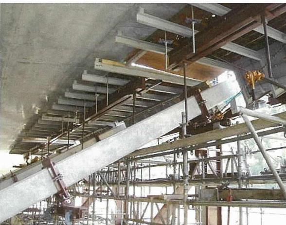
写真 - 9 ストラットセット完了
