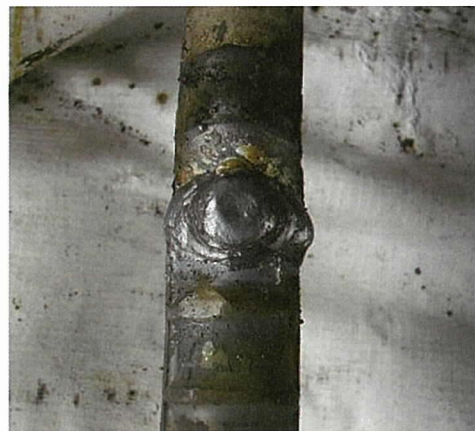
写真 - 11 エンクローズ溶接外観
