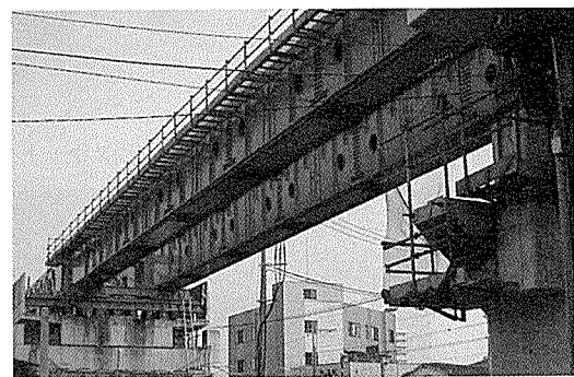
写真-9 桁架設用ガーダーと横取り装置
