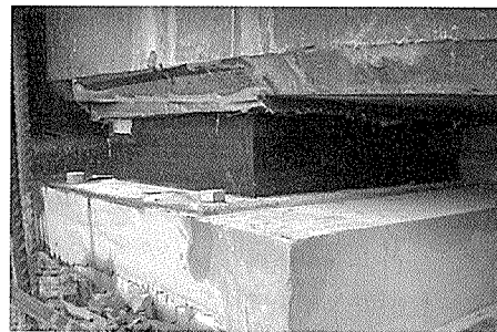
写真 - 5 弾性支承とフラットジャッキの設置 左) 反力移行状況, 右) 完成
