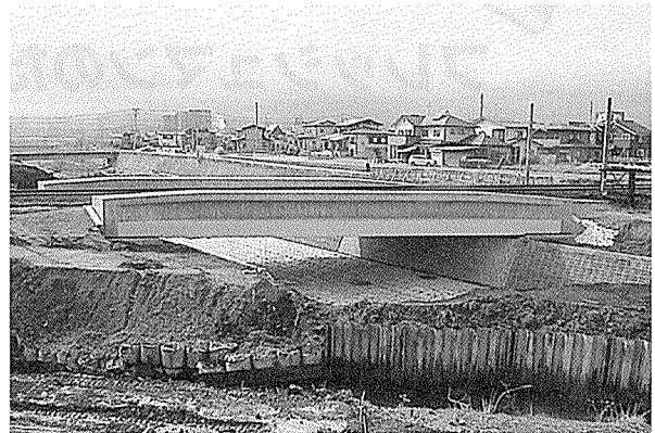
写真 - 1 下路桁形式完成状況
