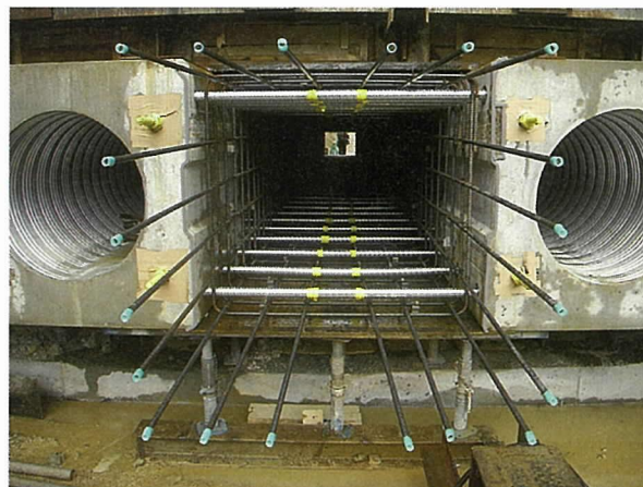
写真 - 13 閉合部の配筋
