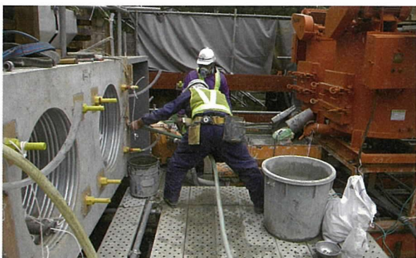
写真 - 11 目地部モルタル注入
