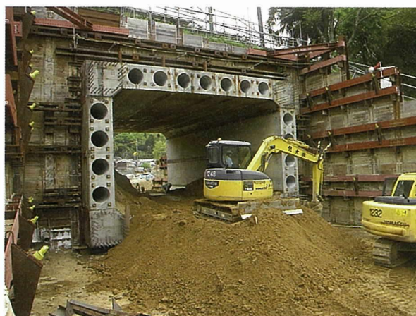
写真 - 14 内空断面掘削状況
