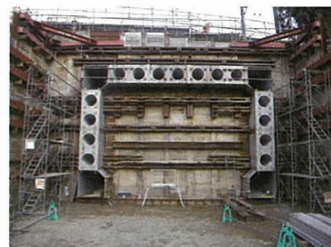
ステップ2 側壁部施工完了
