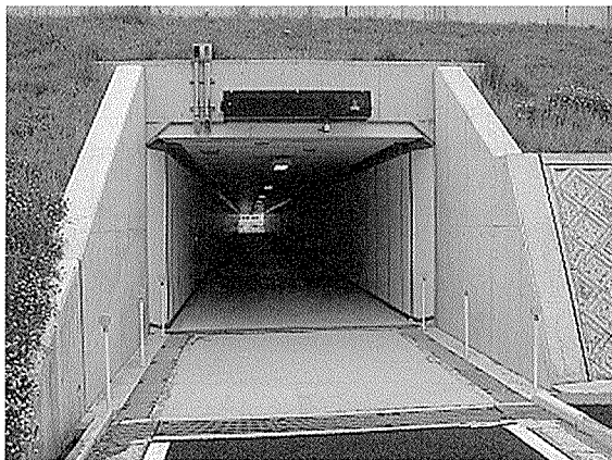
写真 - 3 箱形トンネル形式完成状況
