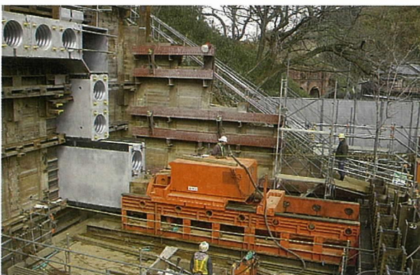
写真 - 12 PCR 桁の置換推進
