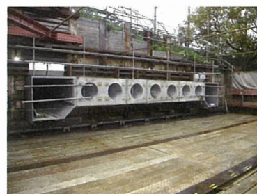
ステップ1 上床部施工完了
