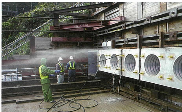
写真 - 10 目地部洗浄
