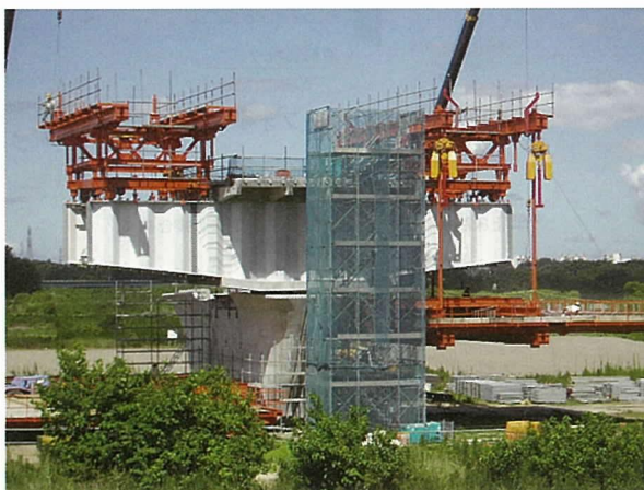
写真 - 5 波形鋼板を架設桁とした施工（鬼怒川橋）
