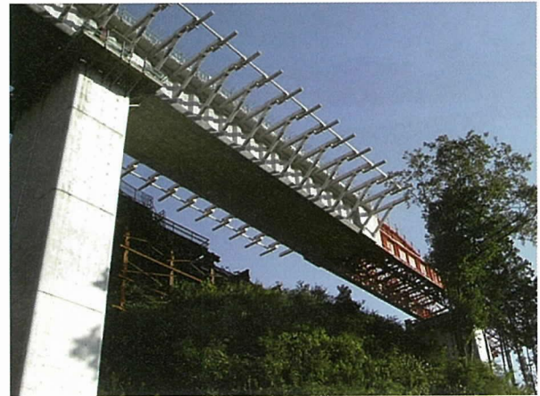
写真 - 6 押し出し架設の施工例（桂島高架橋）
