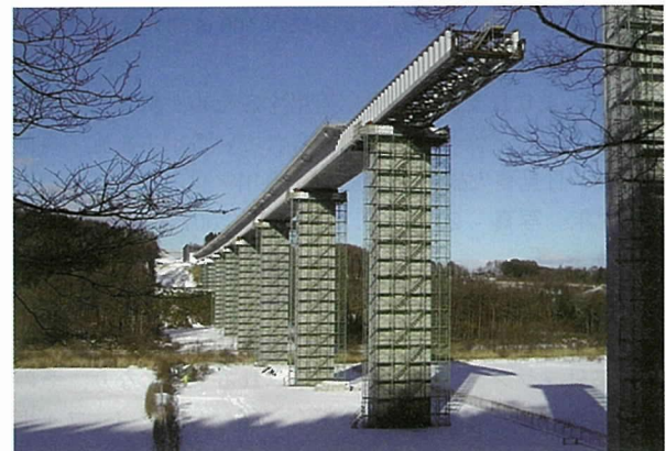
写真 - 7 押し出し架設の施工例（鳥崎川橋）
