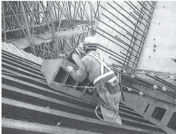
写真 - 1 底版型枠組立て状況
