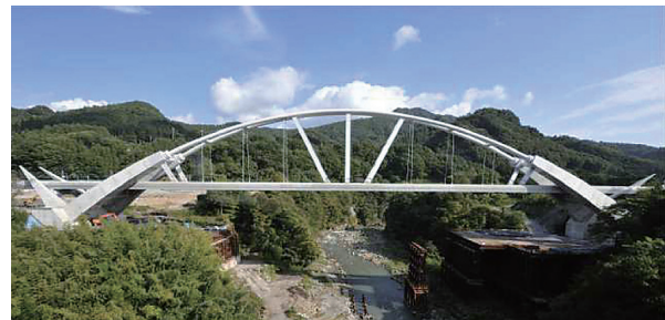
写真 - 7 現況 (完成)
