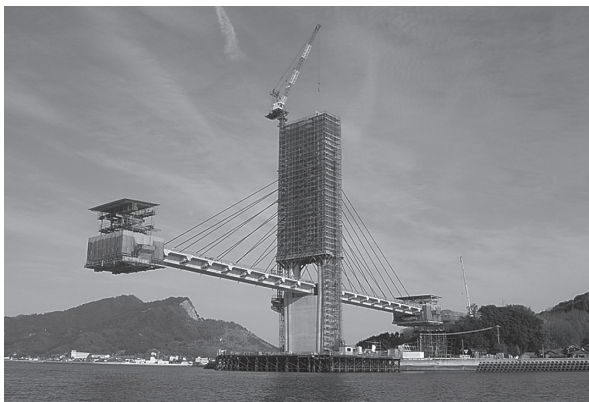
写真 - 7 張出し施工状況
