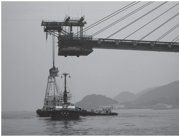
写真 - 10 接合桁架設状況
