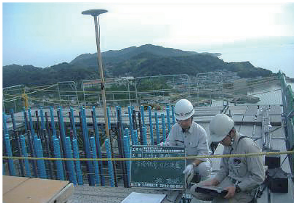
写真 - 4 主塔鉄骨の GPS 測量
