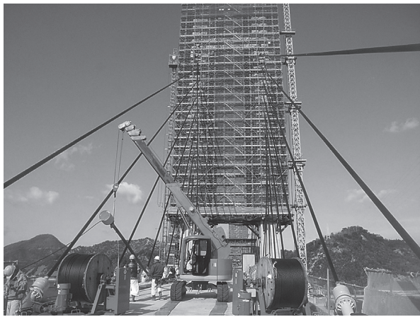
写真-9 斜材架設状況
