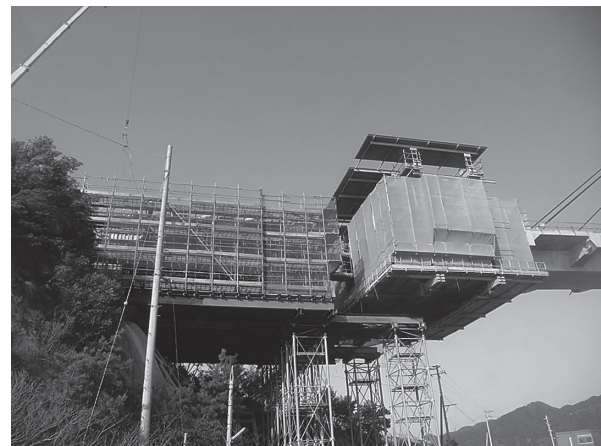
写真 - 8 張出し部と側径間部の同時施工状況
