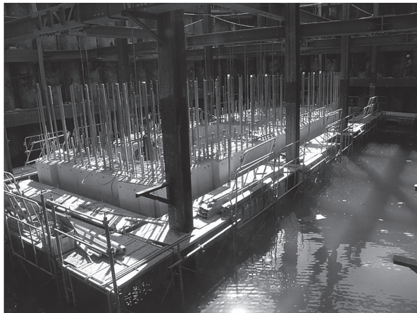
写真 - 2 仮締切り内注水状況
