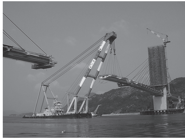
写真 - 12 鋼桁架設状況
