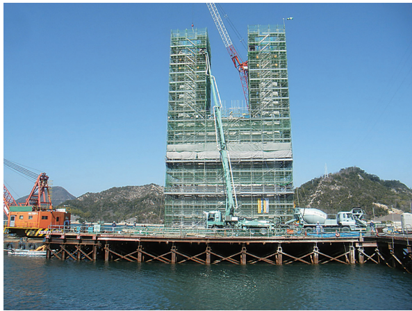
写真 - 3 主塔 3 リフト目の施工状況
