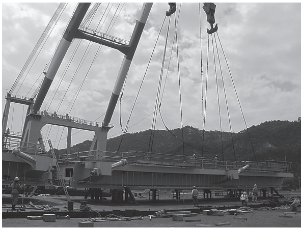
写真 - 11 鋼桁水切り状況
