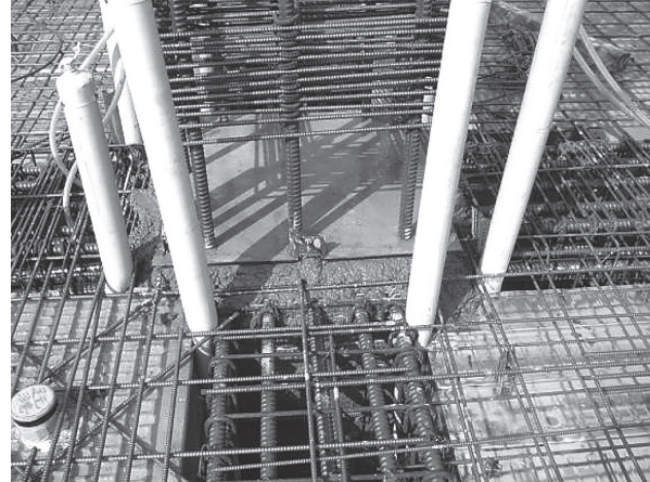
写真 - 1 柱梁接合部コンクリート打設状況
