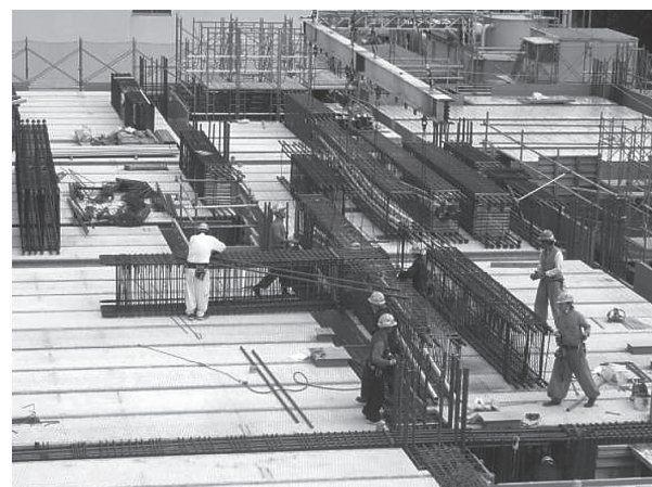
写真 - 3 大梁鉄筋地組状況
