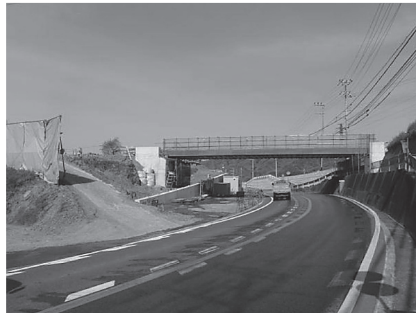
写真 - 7 UFC 桁架設後現場全景
