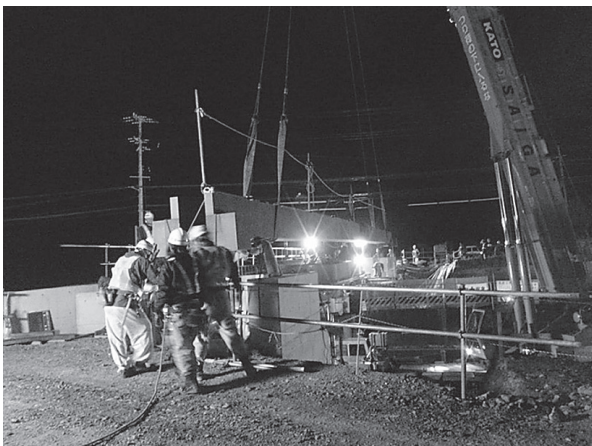
写真 - 6 UFC 桁架設状況
