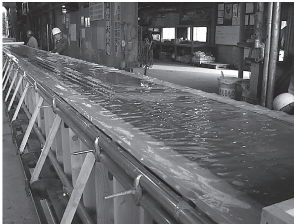
写真 - 2 フィルムによる養生
