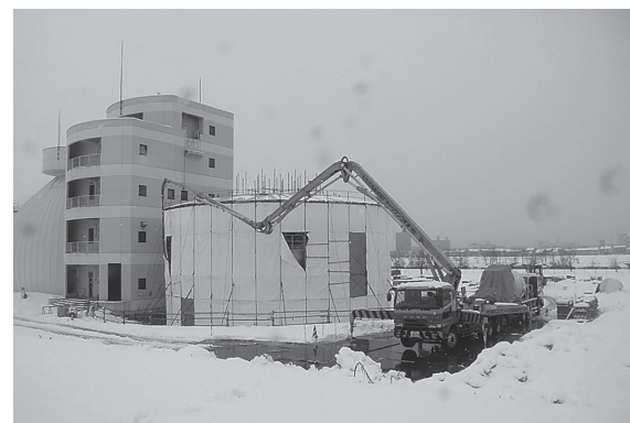
写真 - 5 側壁コンクリート打設状況
