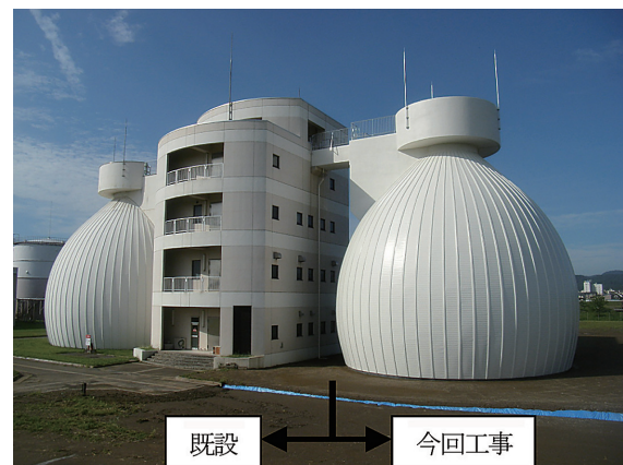
写真 - 9 完成写真
