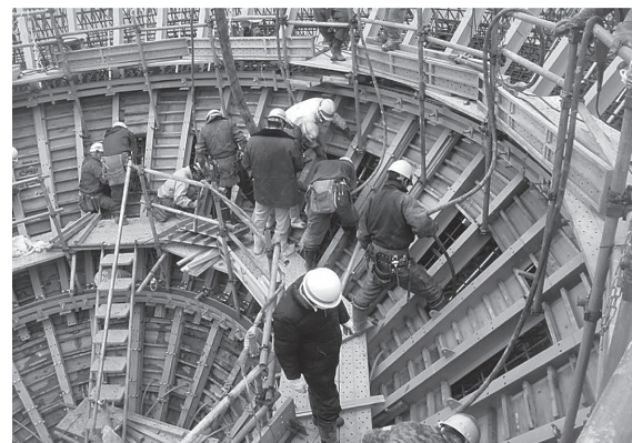
写真 - 3 円錐部コンクリート打設状況
