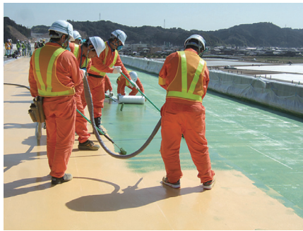
写真 - 6 高性能床版防水工の施工
