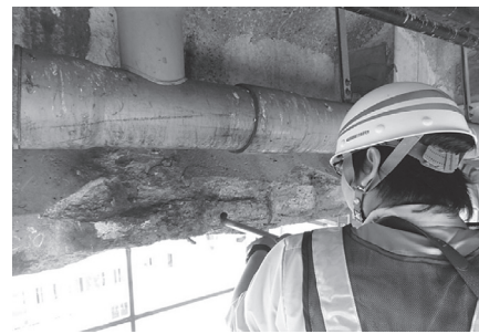
写真-3 超音波穿孔装置を用いた削孔状況
