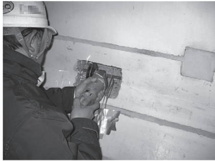
写真 - 5 鉄筋切断法による残存プレストレス測定
