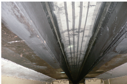
写真 - 7 桁端部の漏水対策（充てん工法）
