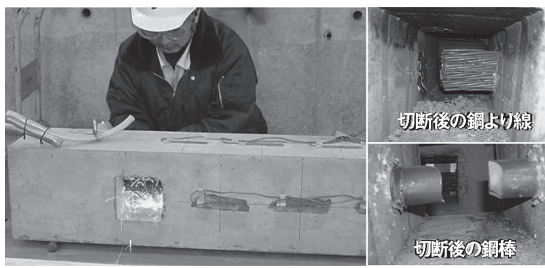
写真 - 2 鋼材破断実験状況
