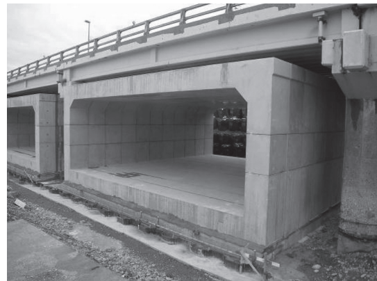
写真 - 11 ボックスカルバート完成
