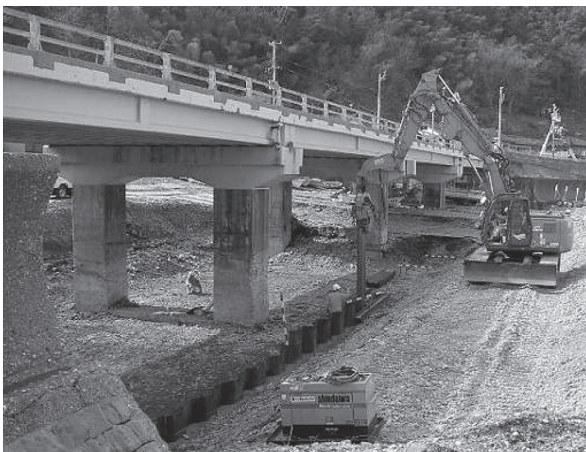
写真 - 6 止水矢板打設
