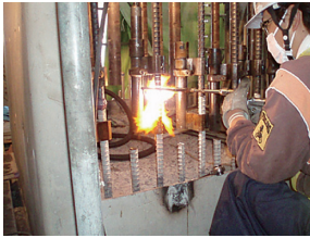
写真 - 16 主鉄筋ガス圧接状況
