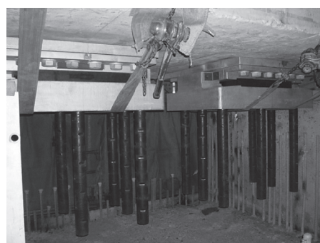
写真 - 15 支承設置完了
