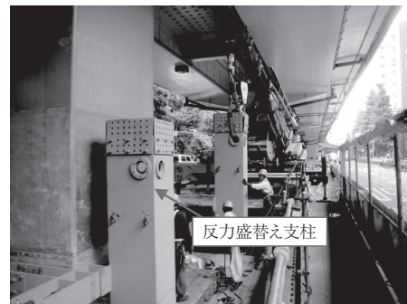
写真 - 5 仮設材組立て状況
