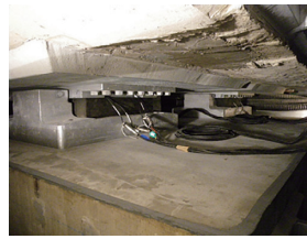
写真 - 21 圧力センサー計測状況
