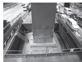
写真 - 3 ライナー掘削
