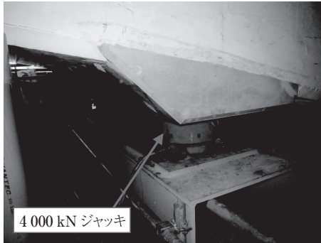
写真-7 ジャッキセット状況
