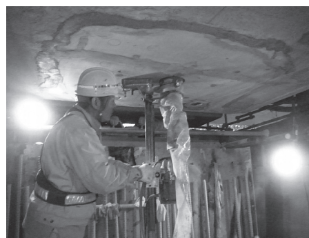
写真 - 13 コアボーリング状況
