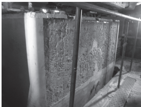
写真-8 鋼板撤去状況
