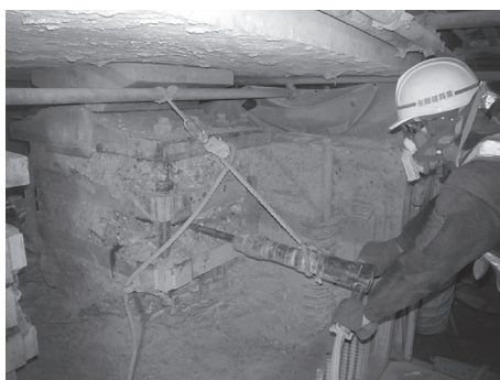
写真 - 11 既設支承撤去状況
