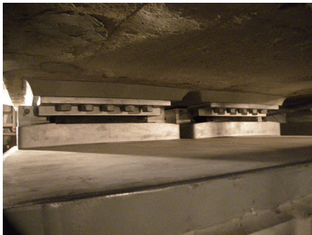
写真 - 20 支承取替え完了
