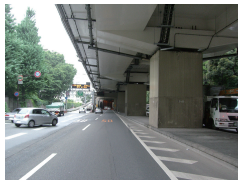
写真-2 施工前全景
