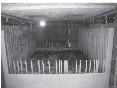
写真 - 12 脚はつり完了状況
