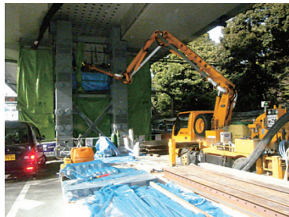
写真 - 19 コンクリート打設
