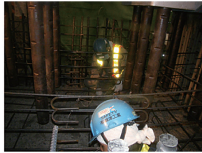
写真 - 17 鉄筋組立て状況
