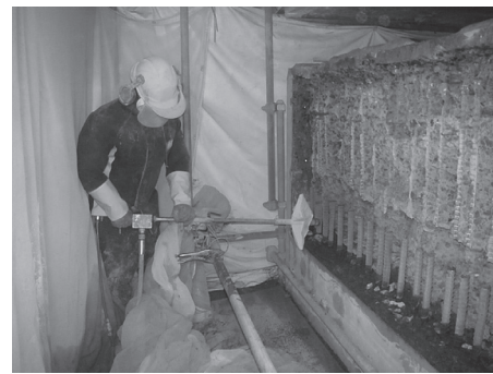
写真-10 ウォータージェットはつり状況
