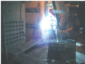
写真 - 18 鋼板復旧状況
